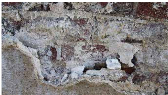
Typischer Schaden durch Salzausblühungen
