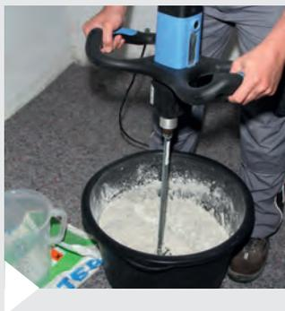
Pro Sack KÖSTER Hydrosilikatkleber SK ca. 5,2 Liter Wasser zugeben und mit einem langsam laufenden Rührwerk zu einer homogenen, klumpenfreien Masse anrühren.
