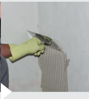
Der KÖSTER Hydrosilikatkleber SK ist anschließend mit einem Zahnschpachtel Schritt für Schritt vollflächig auf den Untergrund aufzutragen.
