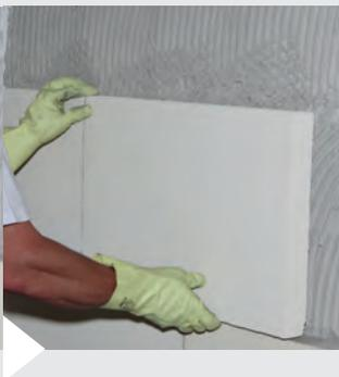
Nach vollständigem Anbringen der KÖSTER Hydrosilikatplatten wird die Oberfläche ggfs. flächenbündig eingeebnet.
