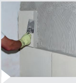
Die Randbereiche der Platten werden mit einer umlaufenden Randwulst aus KÖSTER Hydrosilikatkleber SK versehen, um die Fugenbereiche zwischen den Platten vollständig zu verschließen.
