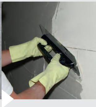
Anschließend wird die gesamte Fläche mit KÖSTER Hydrosilikatkleber SK in einer maximalen Schichtdicke von 2 mm abspachtelt und geglättet. In die Spachtellage ist mittig das KÖSTER Armierungsgewebe einzubetten.
