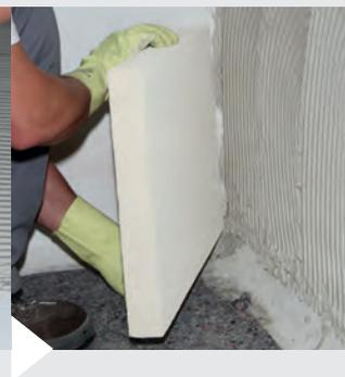
Die KÖSTER Hydrosilikatplatten werden nun auf die Wand gedrückt und dort ausgerichtet. Eine Wasserwaage hilft bei der Ausrichtung.
