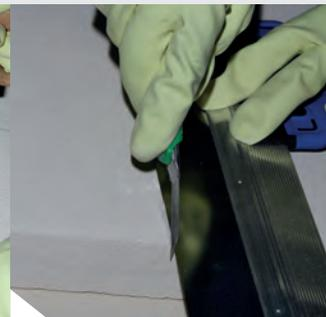
Alternativ kann der Zuschnitt auch mit einem Cutter-Messer entlang einer Schiene erfolgen.
