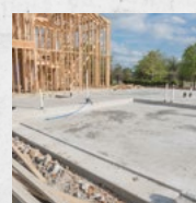
Wand- und Bodenplatten
