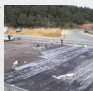
Abdichtung von Bodenplatten
