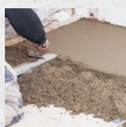
Zur Herstellung von Estrich
