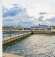
Auffang- und Vorratsbecken
