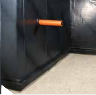
Die Abdichtung ist installiert.
