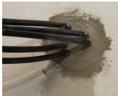
6 ... und dauerhaft abgedichtet.
